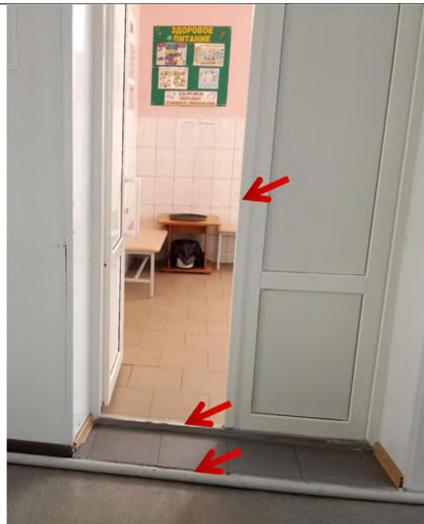
Фото № 22. Дверной проем контрастно не маркирован. Порог в дверном проеме. Препятствие в виде трубы отопления
