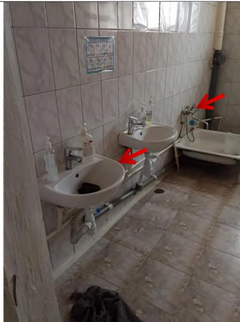
Фото № 28. Нет опорного поручня возле умывальника В душевой кран поворотного типа
