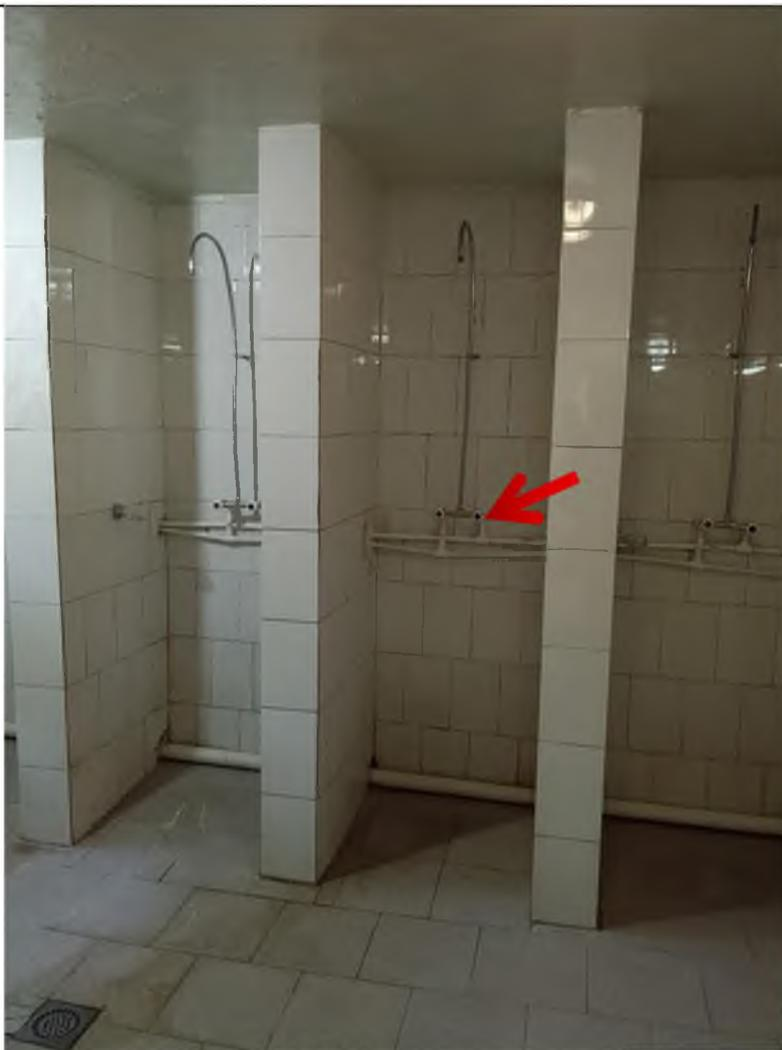
Фото № 29. В душевых краны поворотного типа. Нет опорных поручней
